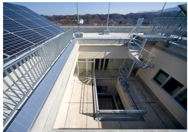
屋上の太陽光発電パネルと中庭
